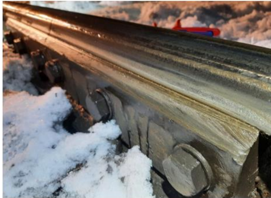
Bild 1. A-anmärkning kraftigt slitage ovanpå skarvjärnet.
