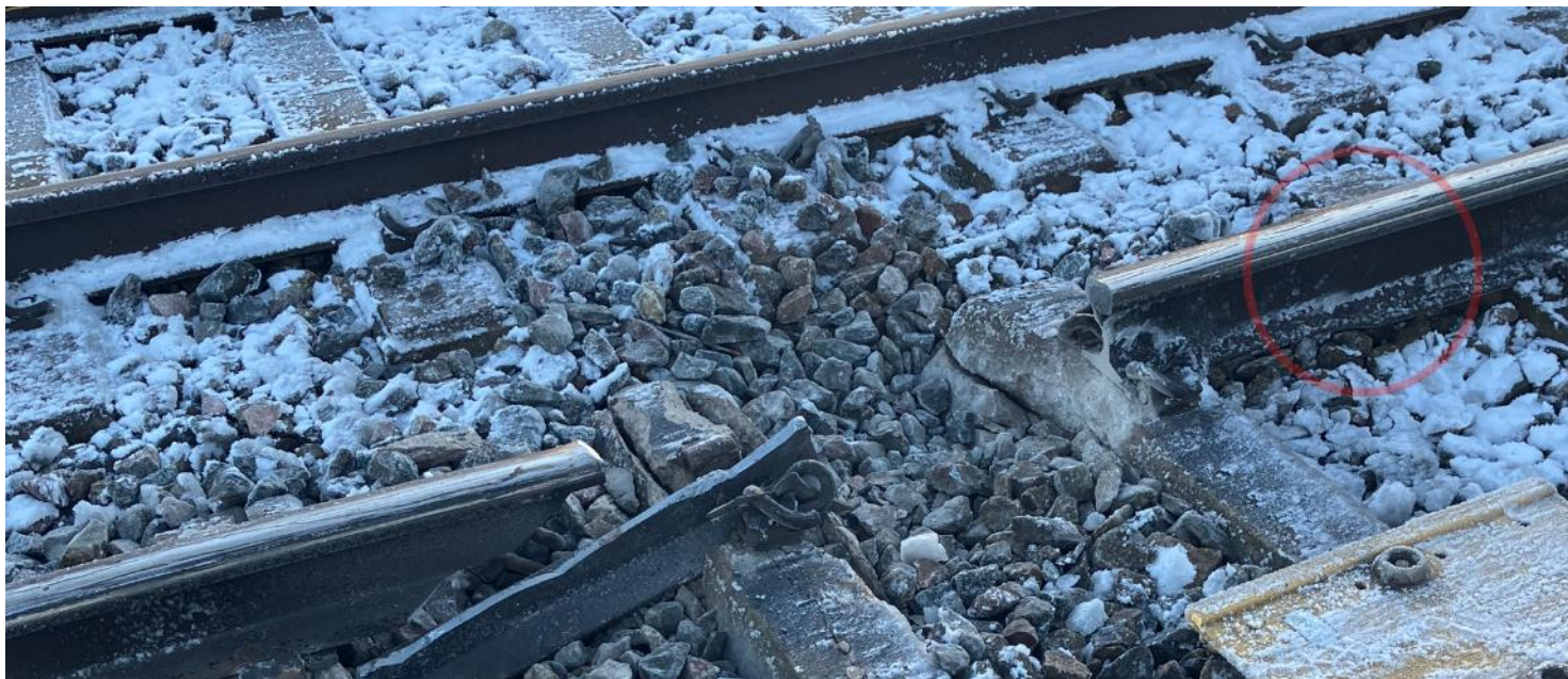
Röd ring är 60-kg delen av övergångsrälen mot spårväxel 102
