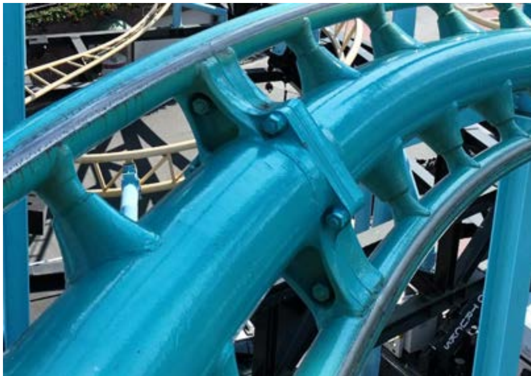
Figur 6. Två bansegment och skarven där de skruvats ihop.
