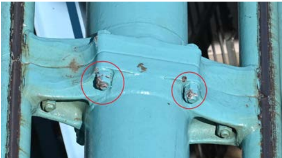
Figur 12. De kraftigare islagsskador på skarvarnas skruvförband syns inom de röda cirkarna.
