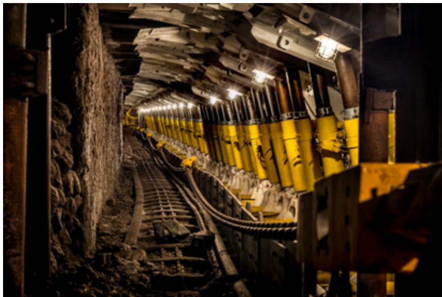
Figur 4. Hydrauliska tackstöd i kolgruva.
