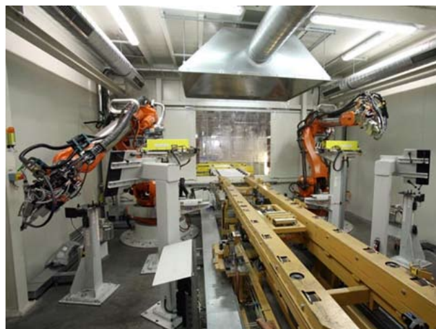
Figur 7. Interiör från den senaste laserinstallationen på Volvo Torslandaverken avsedd för laserlödning kring bakdörrsöppningen på V70-modellerna.
