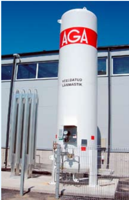
Bild 2. Högtryckstank för flytande nitrogen i Estland.
