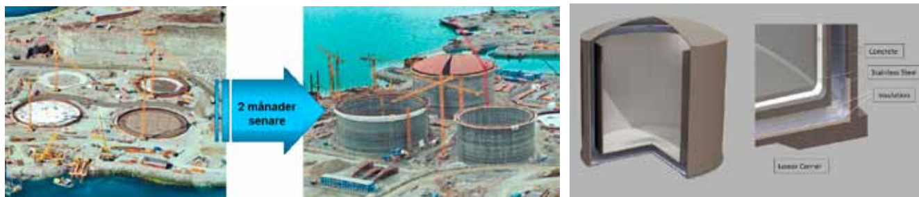
Figur 9. Ovan får man en uppfattning av storleken på de naturgastankar som snabbt byggs upp genom glidgjutning av två betong-cylindrar, och t.h. det nya konceptet där beklädnad med tunna rostfria membran garanterar tankens gastätethet.
