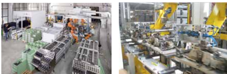
Figur 12. Vid tillverkning av växelförardetaljer hos ERLAS används en avancerad materialhantering vilken innefattar 7 robotar med totalt 54 axlar. T.h. sker den helautomatiserade transfern fram till lasersvetscellen.
