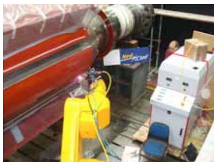
Figur 13. Med hjälp av LASER on demands mobila laserenhet kan denna 40 ton tunga rotor repareras i form av laserpåläggning.
