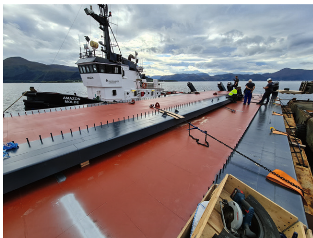
Brudekket er lastet på lekter og er klart for transport til Åfjord kommune. (Foto: Prodtex AS)
